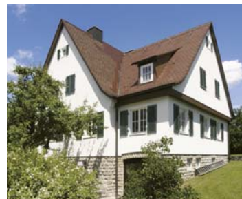
Ältere Bestandsimmobilien gewinnen durch „Jung kauft Alt“ an Attraktivität, bleiben erhalten und werden saniert. (Foto: Bausparkasse Schwäbisch Hall)
